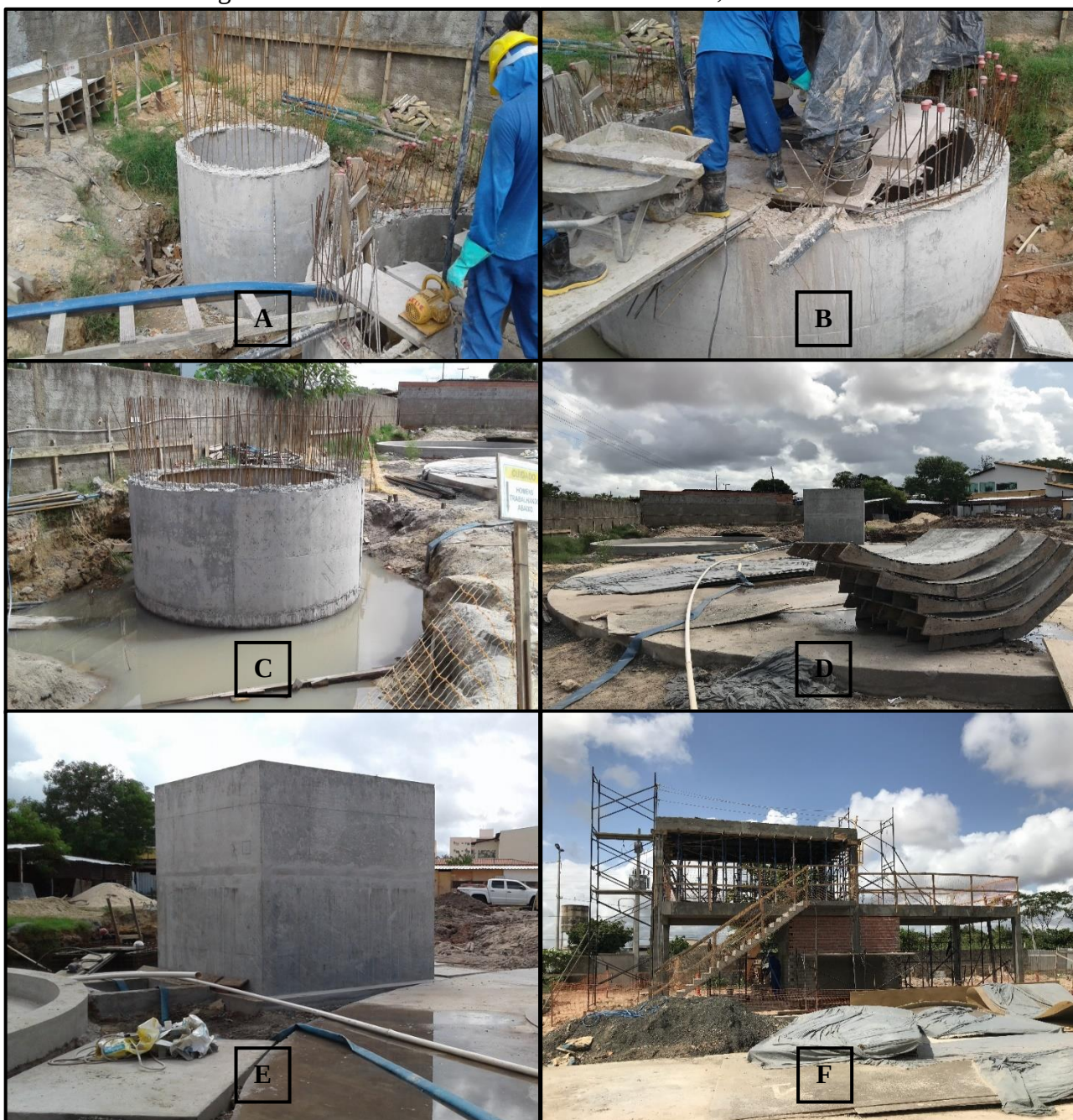
Figura 15 – Obras civis da ETE Tancredo Neves, em 21/01/2020.
