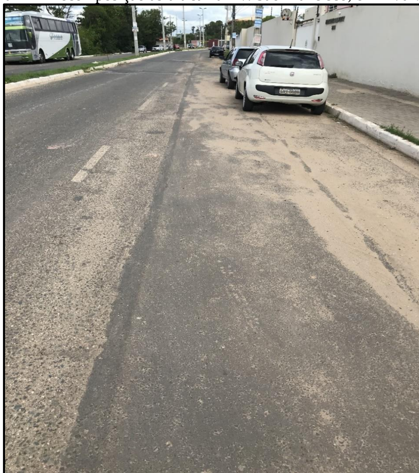
Figura 12 – Recomposição asfáltica na Av. São Francisco, em 21/01/2020.
