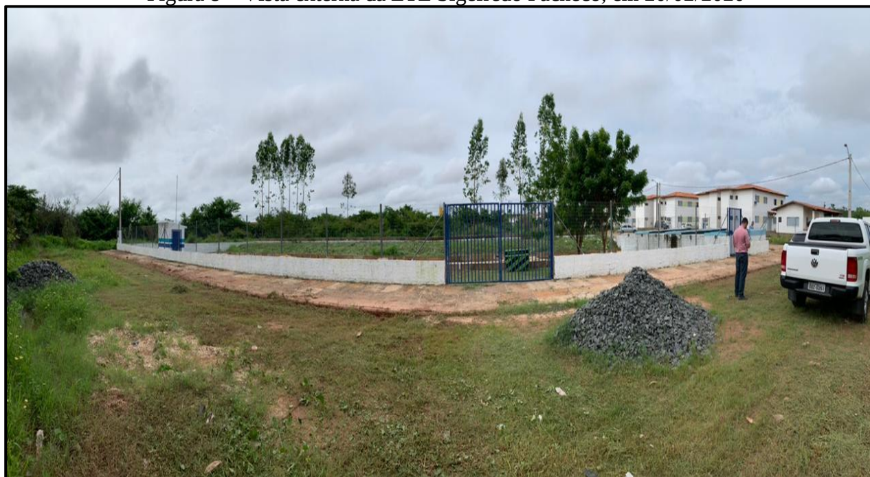
Figura 8 – Vista externa da ETE Sigefredo Pacheco, em 20/02/2020
