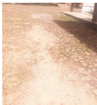
Figura 2 – Rebaixamento de recomposição poliédrica Rua João Pires Barbosa, bairro Aeroporto
