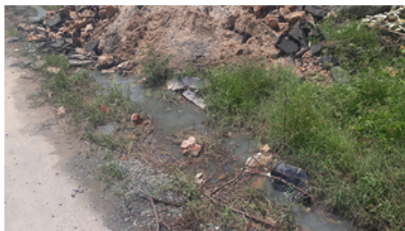
Figura 8 – Entulho das obras acumulado na Rua Coelho de Resende, bairro Aeroporto
