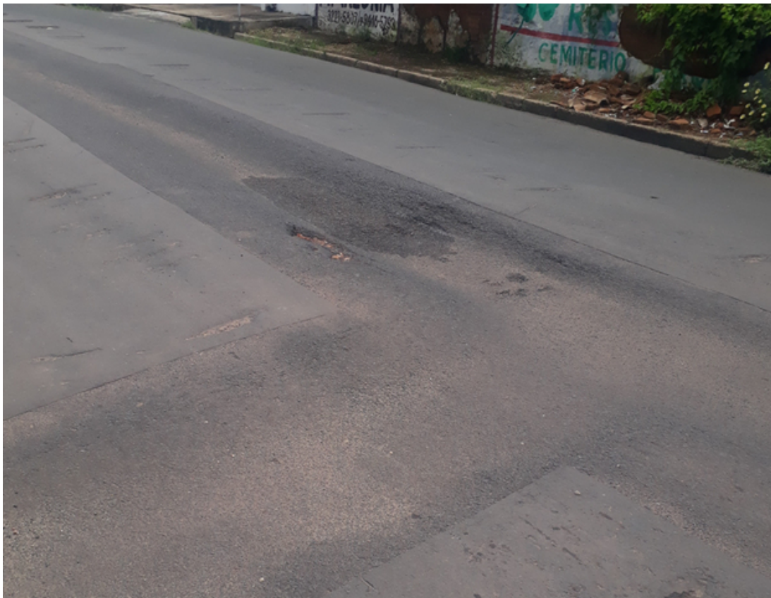
Figura 2 – Rebaixamento de recomposição asfáltica no trecho final da Rua Picos, prox. à Av. Odilon Araújo, bairro Monte Castelo
