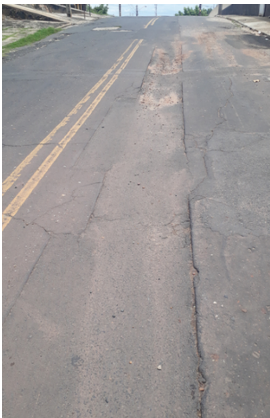
Figura 12 – Desnível provocado por rebaixamento de pavimento, Rua Desembargador Mota, bairro Monte Castelo
