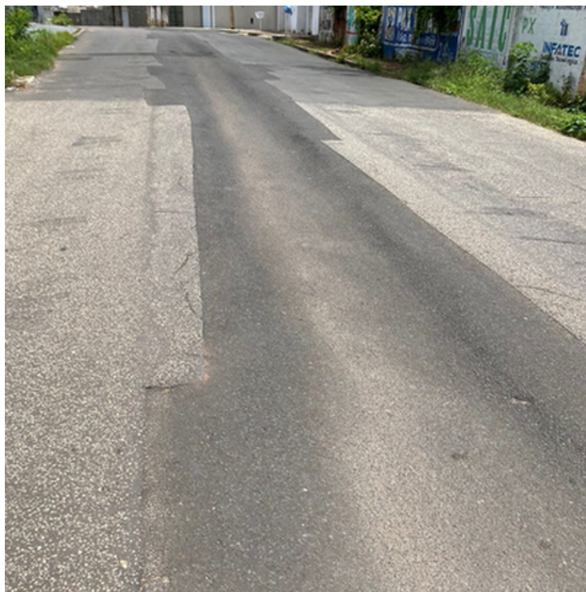
Figura 4 – Rebaixamento de recomposição asfáltica na Rua Picos, bairro Monte Castelo
