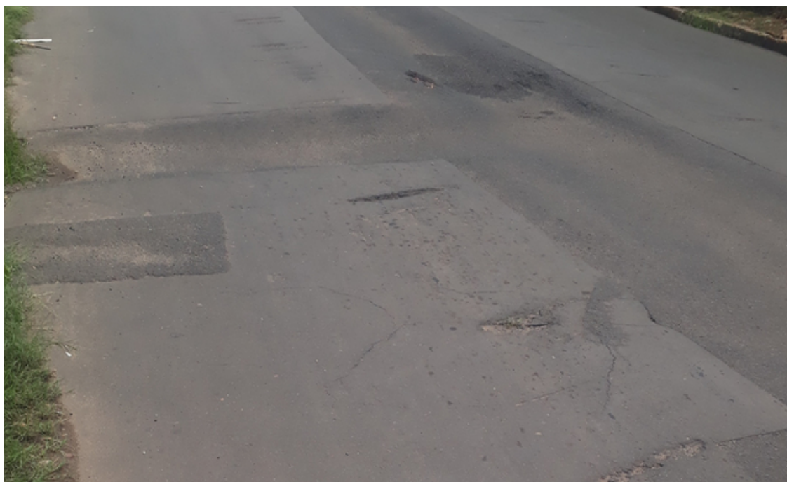
Figura 4 – Rebaixamento de recomposição asfáltica na Rua Picos, bairro Monte Castelo
