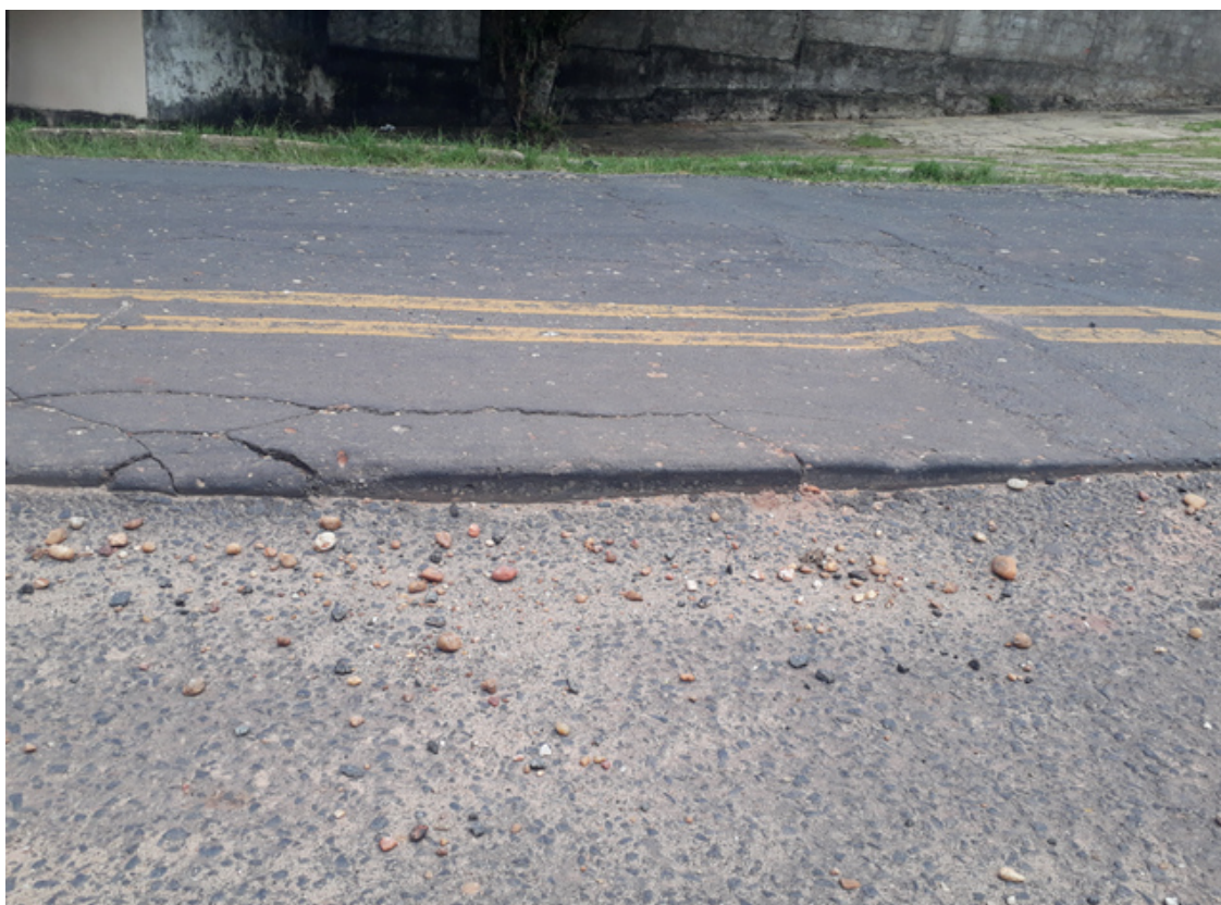
Figura 12 – Desnível provocado por rebaixamento de pavimento, Rua Desembargador Mota, bairro Monte Castelo
