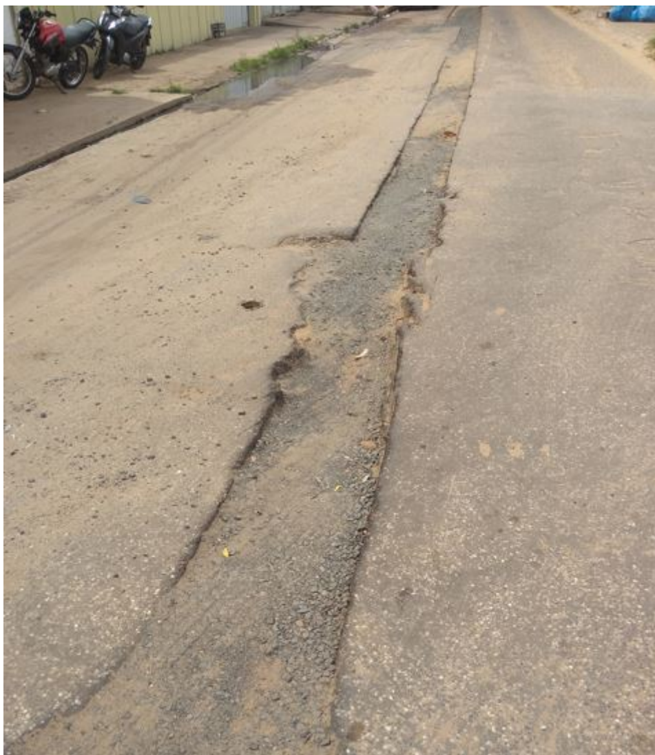
Figura 19 – Apenas parte do trecho da Av. Guaporé foi recomposto, próximo à Rua Coelho de Resende, com a parte próxima ao Aeroporto incompleto
