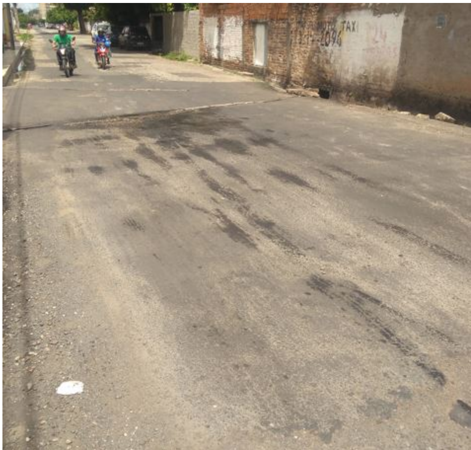
Figura 6 – Correções no repcapeamento asfáltico da Rua Primeiro de Maio.
