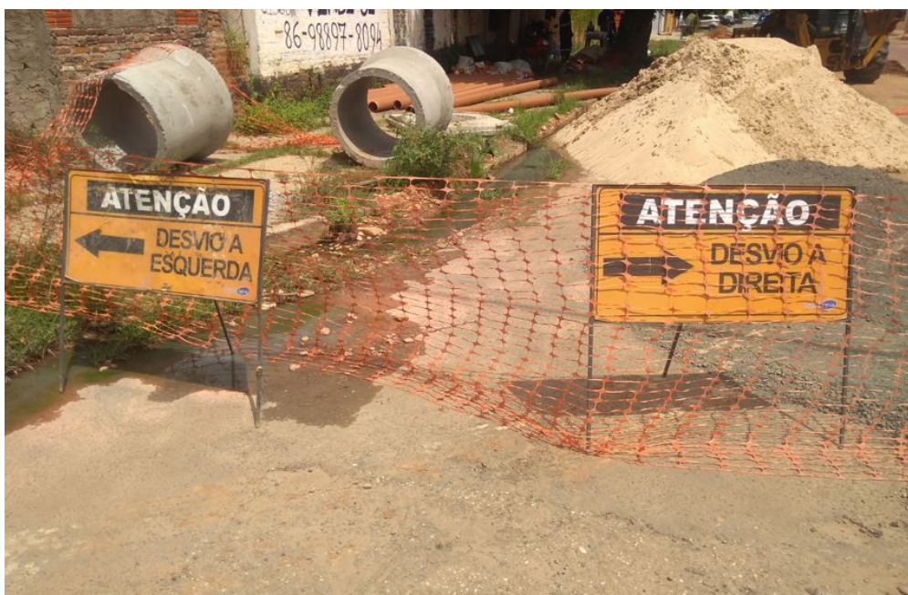
Figura 4 – Sinalização de obras em placas e proteção do canteiro de obras com rede, na Av. Território Fernando de Noronha.
