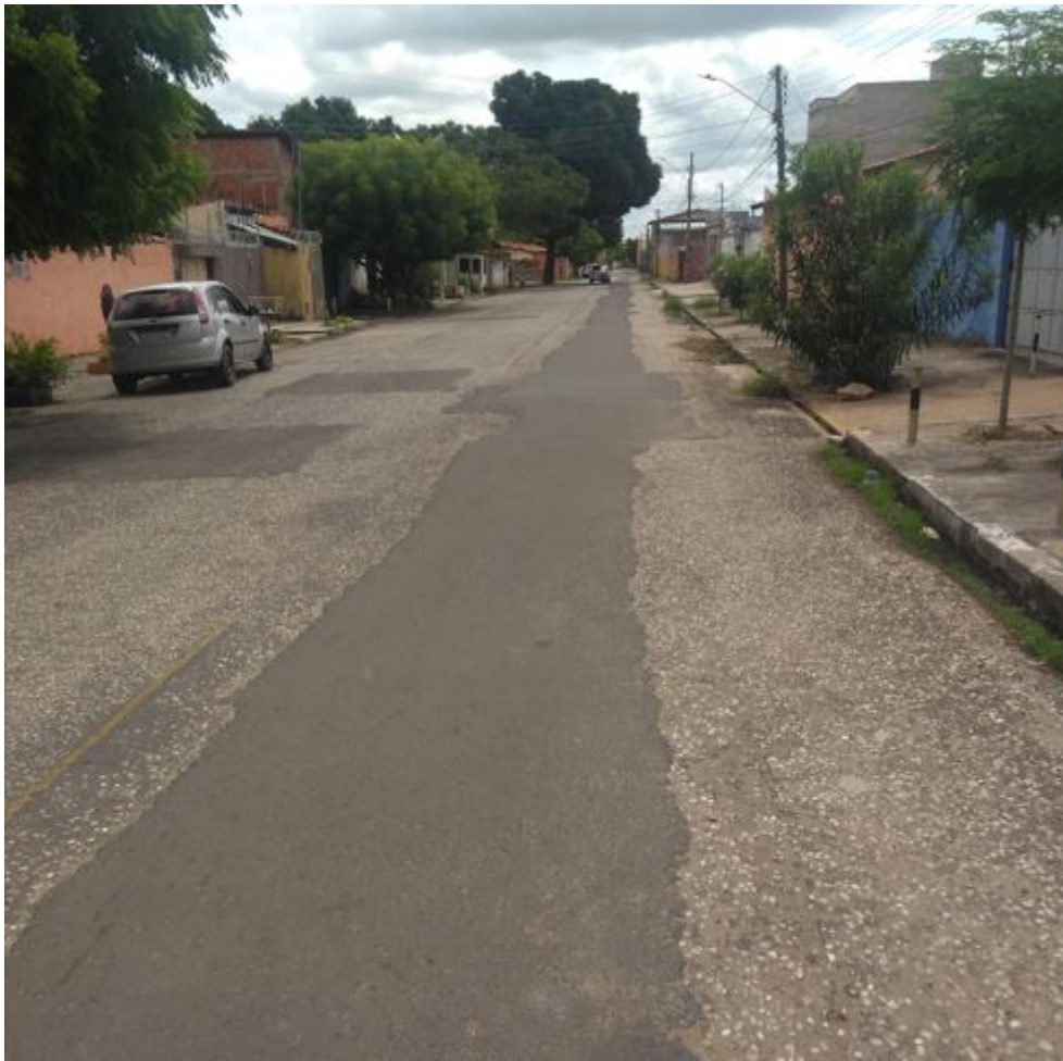
Figura 6 – Correções no repcapeamento asfáltico da Rua Primeiro de Maio.
