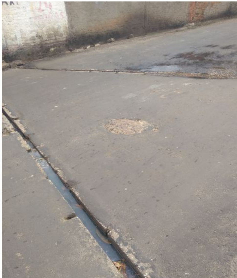
Figura 7 – Correções no recapeamento asfáltico e Poço de Visita da Rua Primeiro de Maio.
