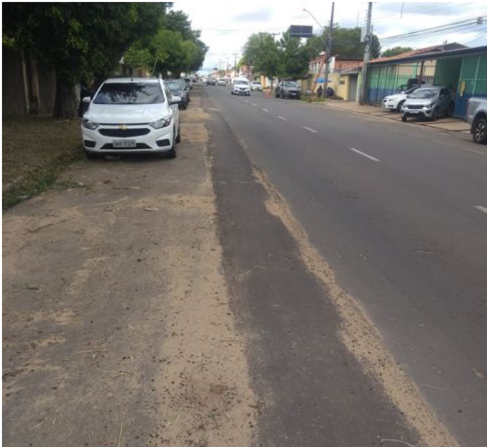
Figura 1 – Recapeamento asfáltico das valas da Rua Coelho de Resende.
