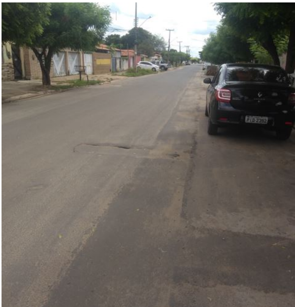
Figura 11 – Afundamento de pavimento asfáltico em vala na Rua Coelho de Resende
