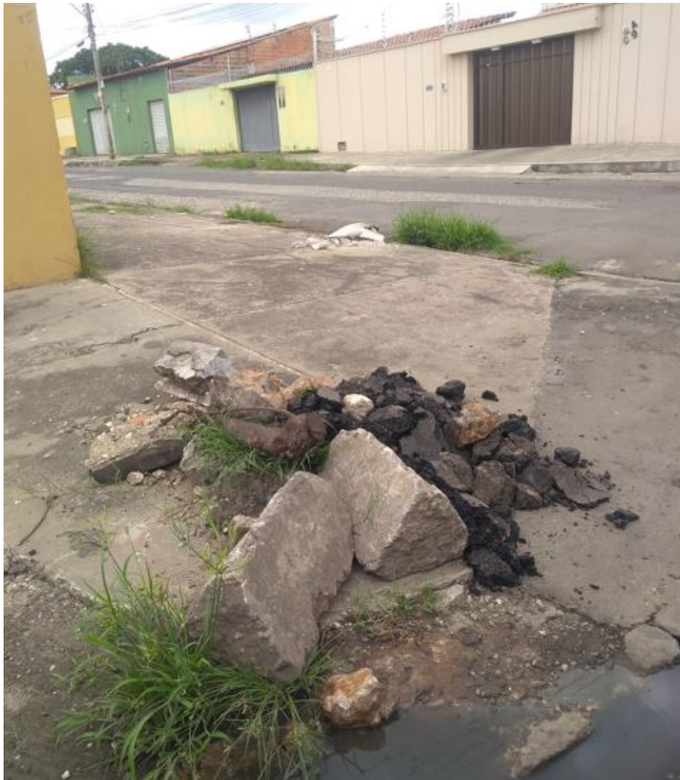
Figura 16 – Sinalização deficitária na Av. Território Fernando de Noronha, em valas ainda não revestidas
