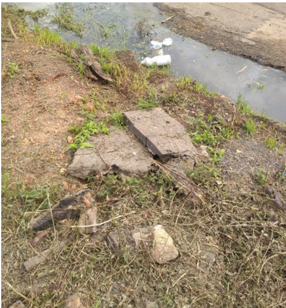
Figura 10 – Entulho de obra (revestimento asfáltico) depositado ao lado da Av. Guaporé
