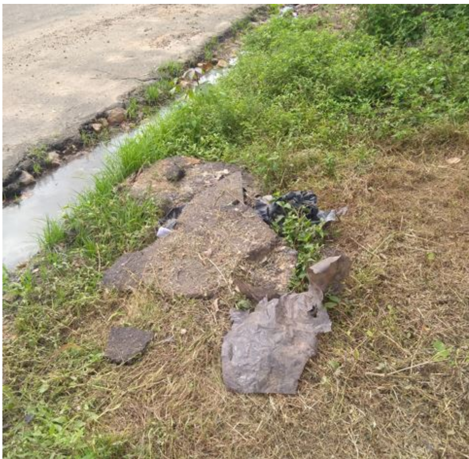
Figura 11 – Afundamento de pavimento asfáltico em vala na Rua Coelho de Resende
