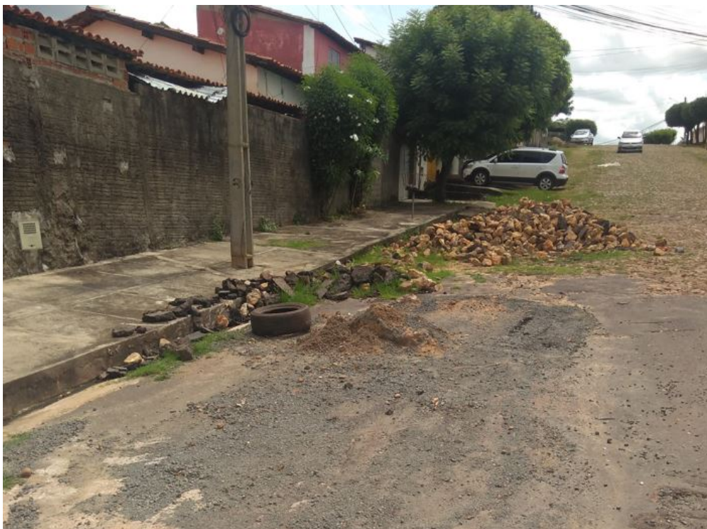
Figura 12 – Resíduos de construção civil (revestimento asfáltico e pedras de mão) depositados em via pública e calçada na Rua Primeiro de Maio, esquina com Av. Território Fernando de Noronha
