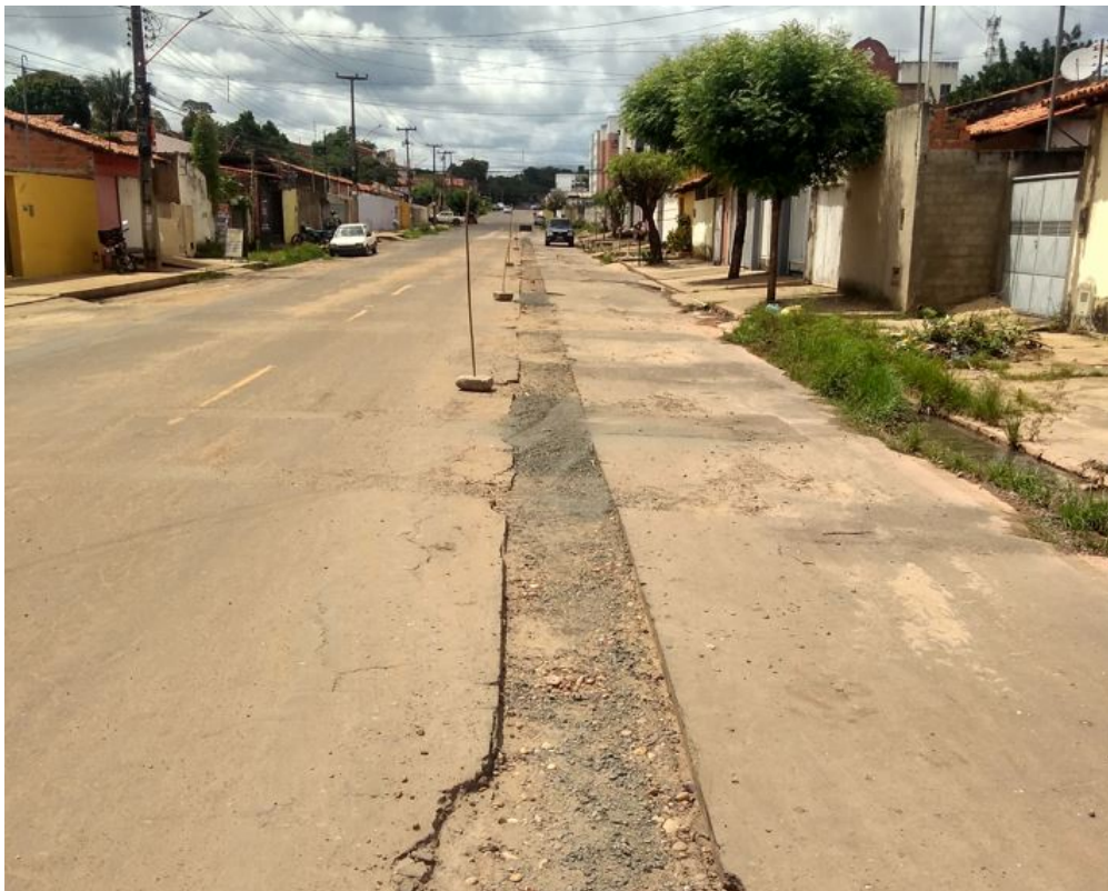
Figura 16 – Sinalização deficitária na Av. Território Fernando de Noronha, em valas ainda não revestidas
