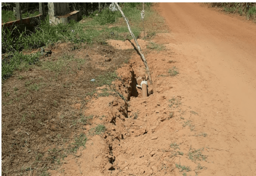
Figura 4 – Vala aberta à frente do poço e reservatório da Associação dos Moradores do Soturno
