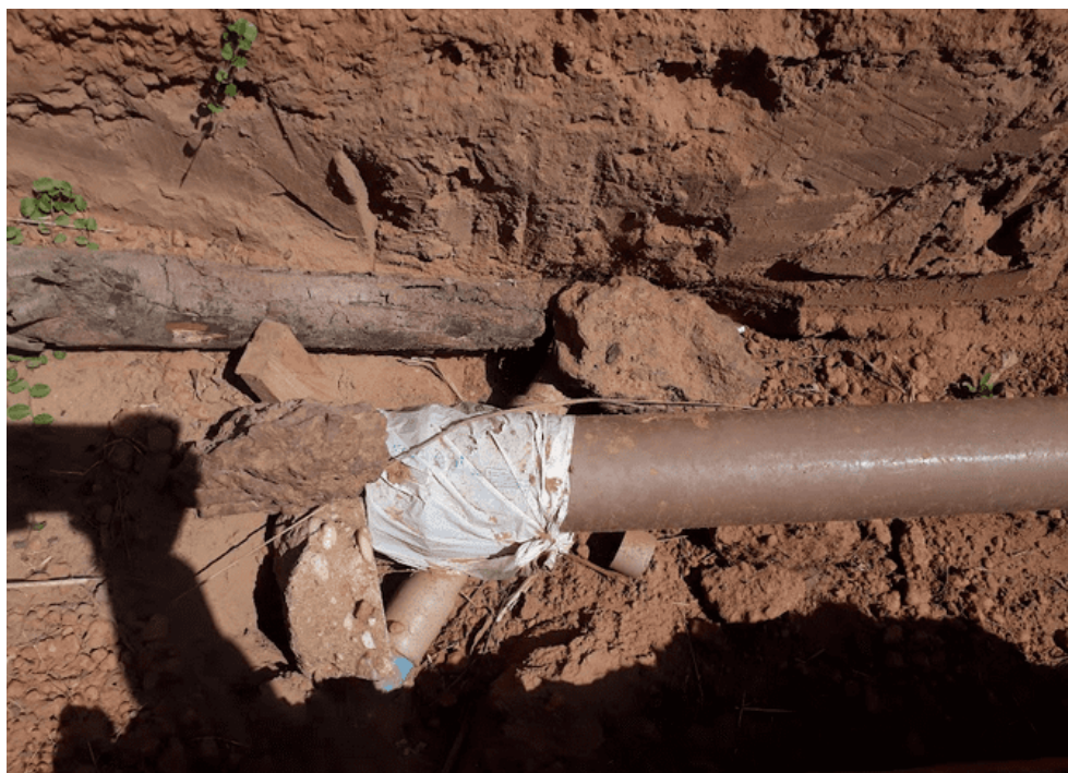
Figura 3 – Início da rede implantada, tubo de 100mm, à frente do poço e reservatório da Associação dos Moradores do Soturno
