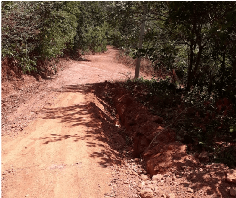
Figura 12 – Detalhe da vala aberta na Rua Projetada 10.
