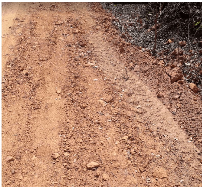
Figura 8 – Alinhamento da instalação da rede de 60mm na curva da Rua Área Verde com a Rua Projetada 10.
