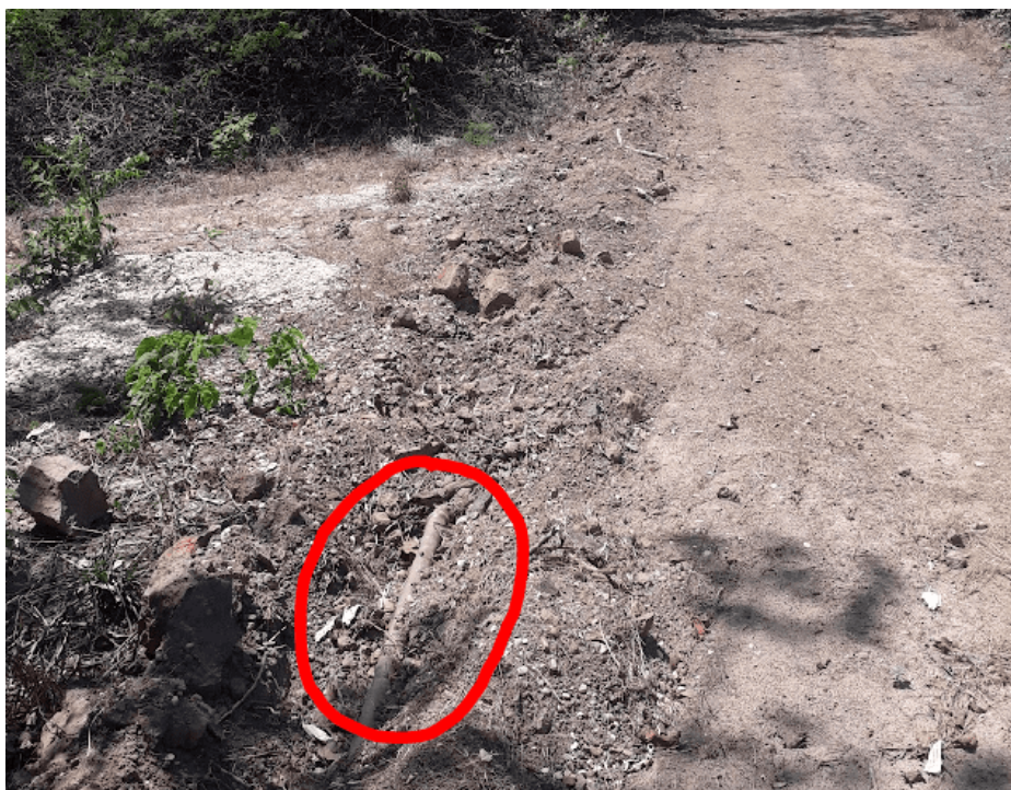
Figura 10 – Rede de 60mm exposta na Rua Projetada 10.
