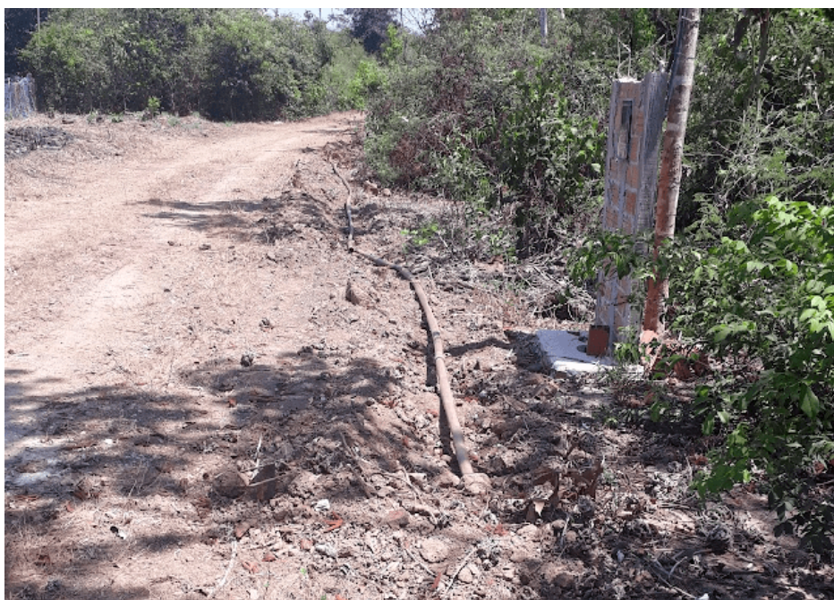
Figura 10 – Rede de 60mm exposta na Rua Projetada 10.
