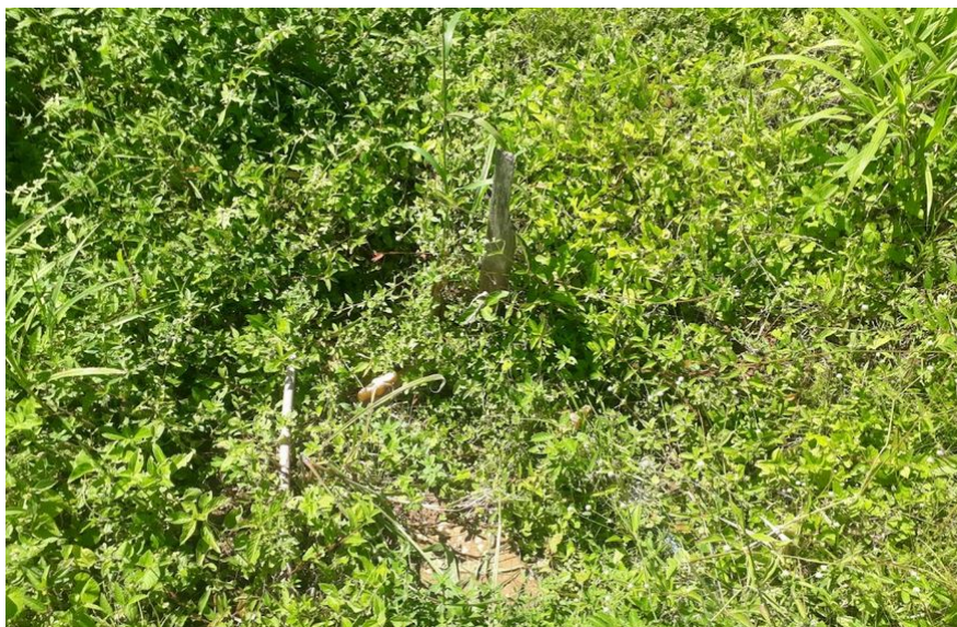
Figura 4 – Vala aberta coberta de vegetação. Verifica-se na imagem o registro para as manobras e parte da tubulação.
