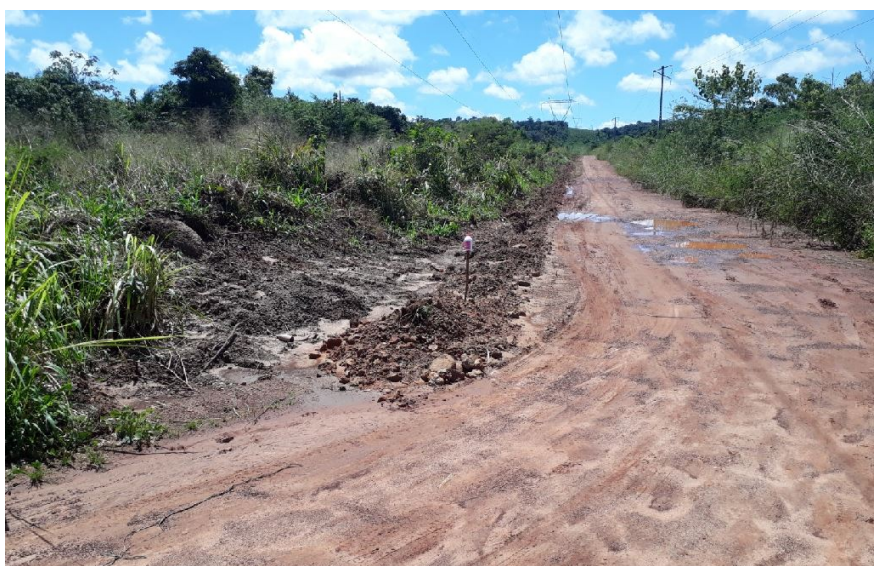
Figura 13 – Trecho final de implantação da rede de abastecimento no Soturno (Rua Fio da CHESF).
