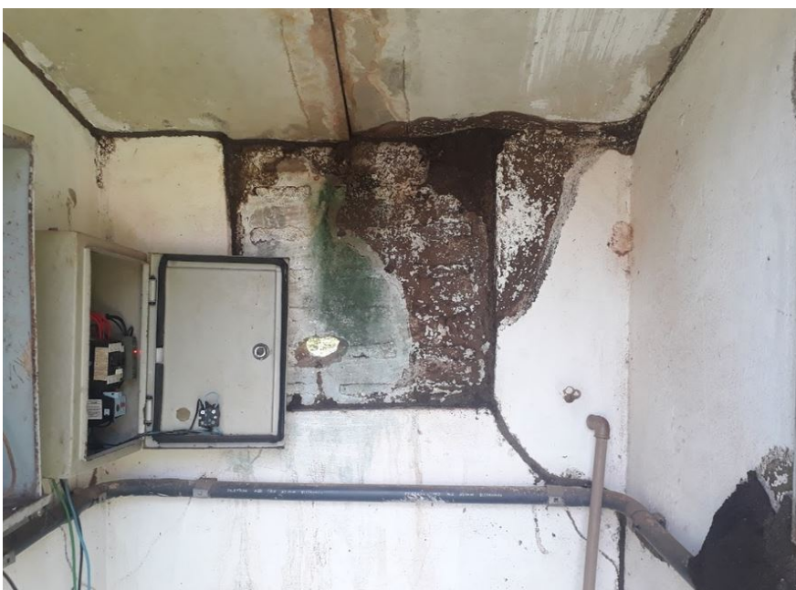
Figura 8 – Interior do abrigo elétrico.
