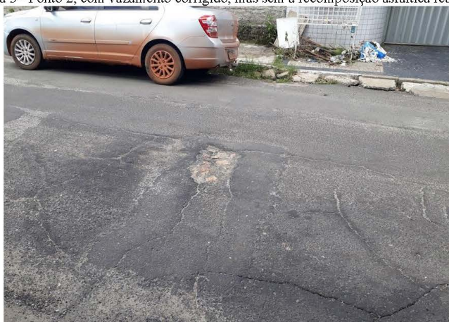
Figura 3 - Ponto 2, com vazamento corrigido, mas sem a recomposição asfáltica realizada.
