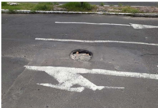
Figura 3 - Ponto 2, com vazamento corrigido, mas sem a recomposição asfáltica realizada.
