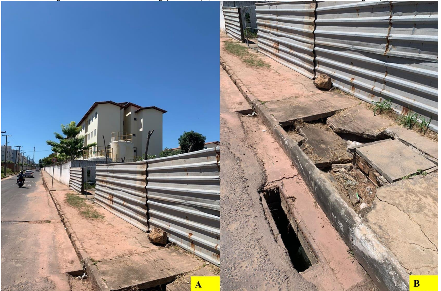
Figura 10 – ETE Residencial Ágape Norte (A) e Ponto de lançamento de esgoto na Drenagem (B)
