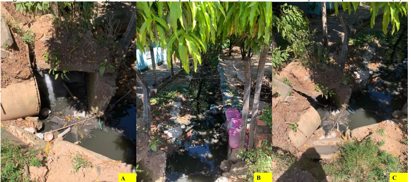
Figura 11 – Ponto em que a drenagem urbana deságua nas propriedades (A e C) e Estruturas de contenção criadas pelos moradores (B)
