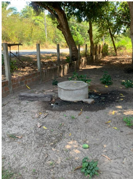
Figura 12 – Provável sistema de tratamento de esgoto com solo saturado
