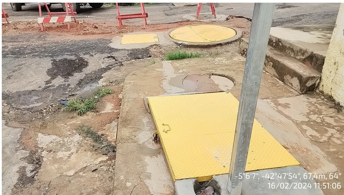
Figura 3 - Execução de Estação Elevatória de Esgoto localizada na Rua Ary Barroso com Rua Profa Zefinha Ferraz, bairro Monte Castelo.
