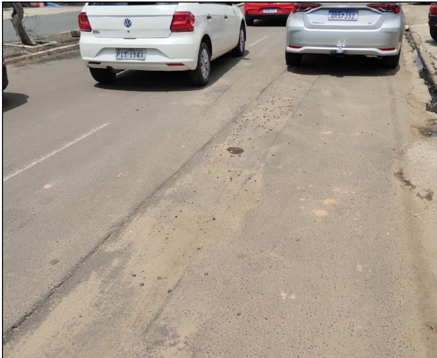
Figura 5 – Recalque e resíduos de obra (areia e brita) em recomposição asfáltica na Av. Miguel Rosa, em frente à Pax União.
