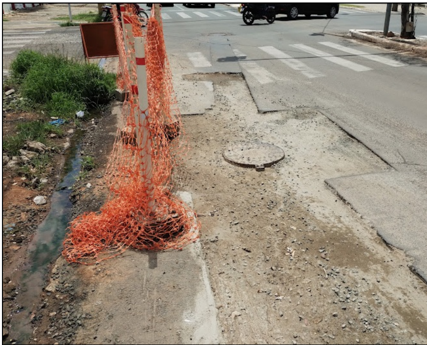
Figura 5 – Recalque e resíduos de obra (areia e brita) em recomposição asfáltica na Av. Miguel Rosa, em frente à Pax União.
