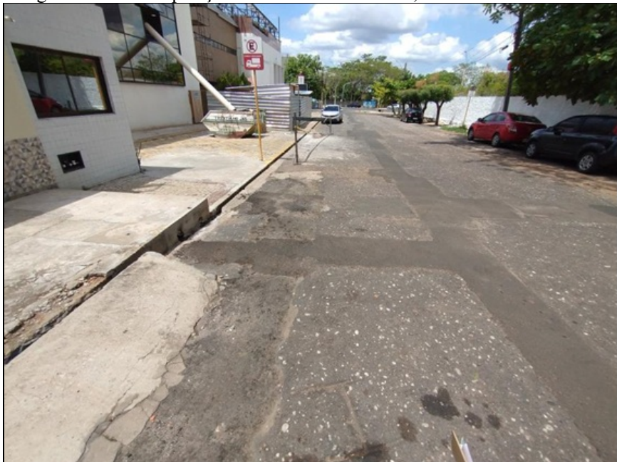
Figura 12 – Recomposição em desnível com a via, Rua Primeiro de Maio.
