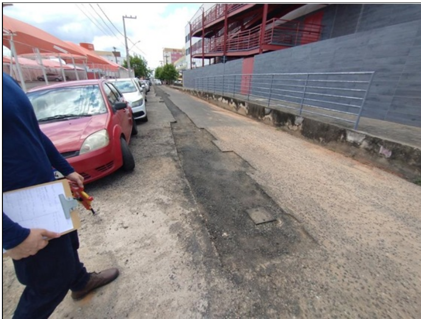
Figura 9 – Fissuras próximas aos cortes na R. Taumaturgo de Azevedo ao lado do Hospital São Marcos.
