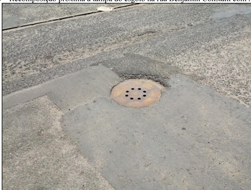
Figura 20 – Recomposição próxima a tampa do esgoto na rua Benjamin Constant com Area Leão.
