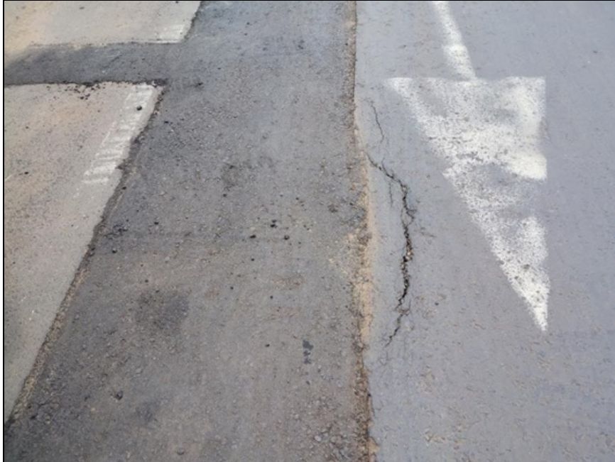
Figura 30 – Rachaduras oriundas da recomposição de valas na Av Campos Sales
