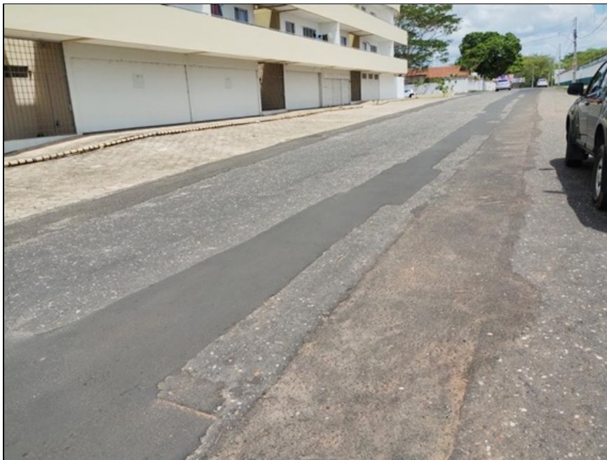
Figura 12 – Recomposição em desnível com a via, Rua Primeiro de Maio.
