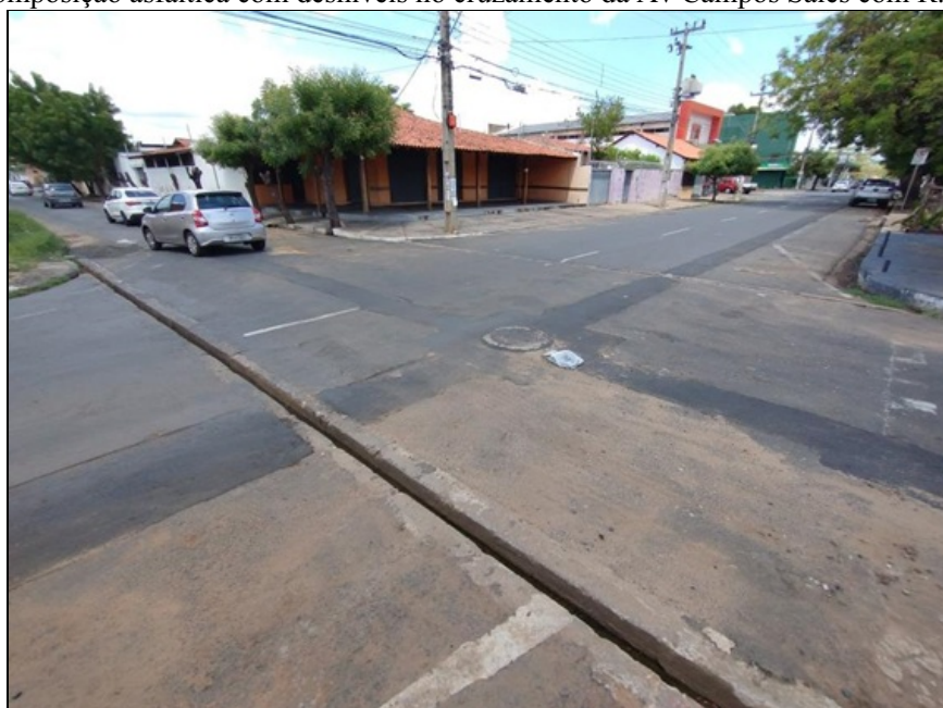
Figura 26 – Recomposição asfáltica com desníveis no cruzamento da Av Campos Sales com R. Anísio de Abreu.
