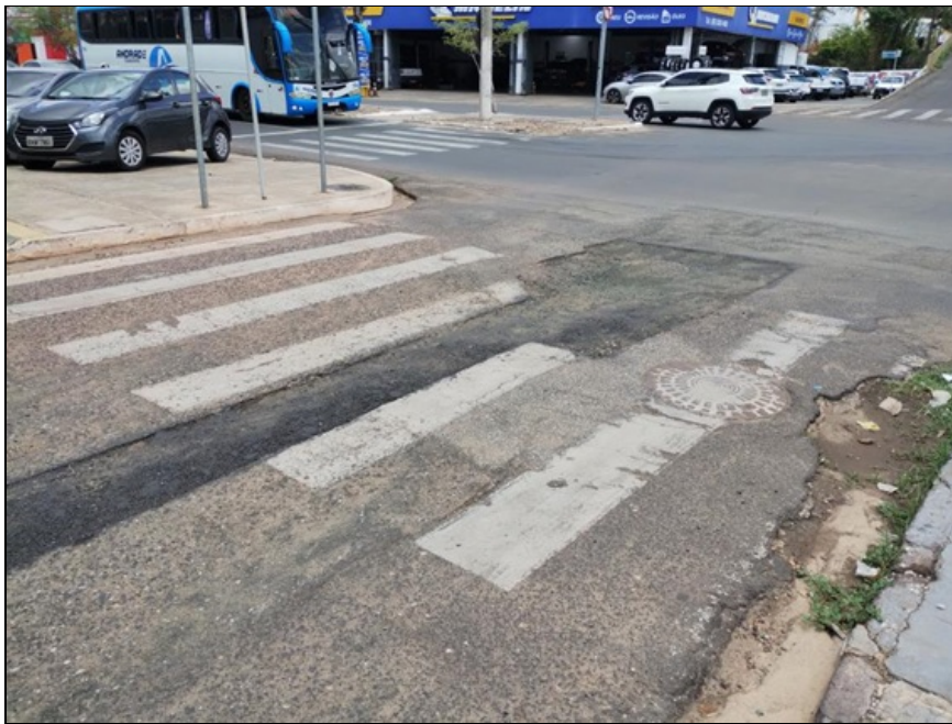
Figura 7 – Recomposição de vala na R. Taumaturgo de Azevedo, próx. ao Corpo de Bombeiros, na manhã do dia 27 de dezembro.
