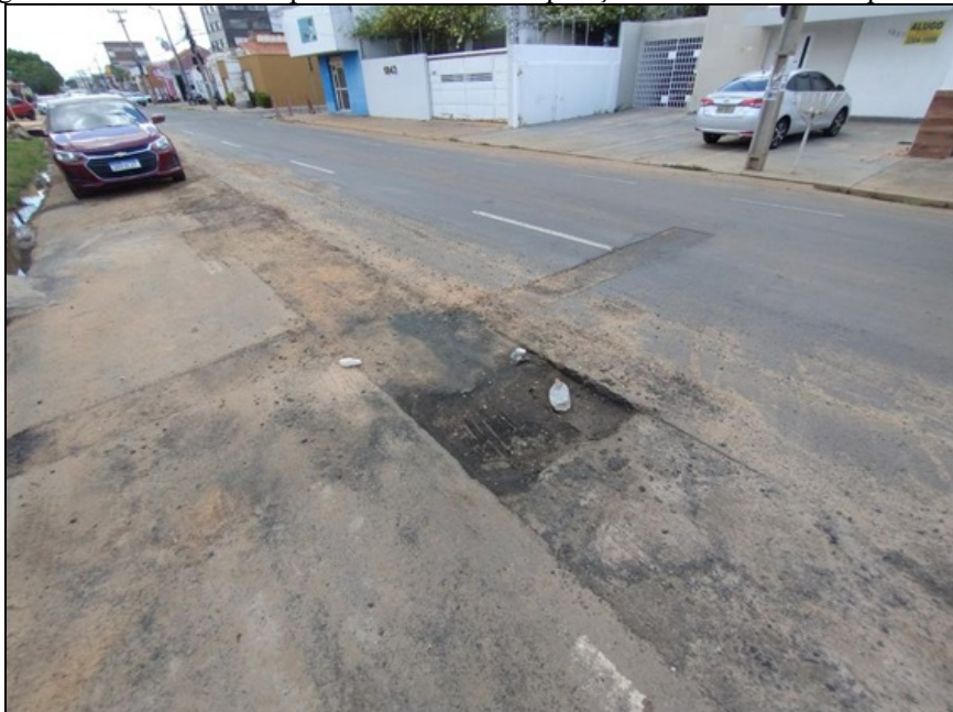
Figura 28 – Brita solta na pista e vala de recomposição aberta na Av Campos Sales.
