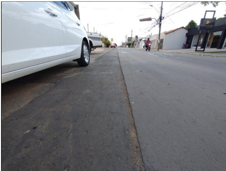
Figura 28 – Brita solta na pista e vala de recomposição aberta na Av Campos Sales.
