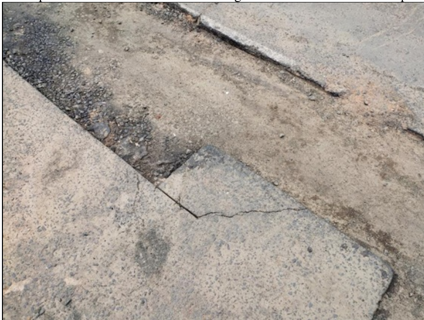
Figura 9 – Fissuras próximas aos cortes na R. Taumaturgo de Azevedo ao lado do Hospital São Marcos.
