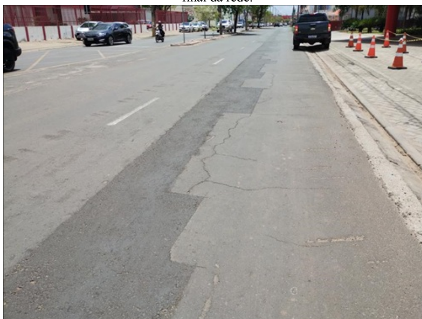
Figura 2 – Recomposição asfáltica de vala na Av Miguel Rosa, em frente ao Hospital São Marcos. Destaca-se as falhas no asfalto recomposto e nas marcas de maquinário no asfalto preexistente, além do corte desnecessário à via, para além do ponto final da rede.
