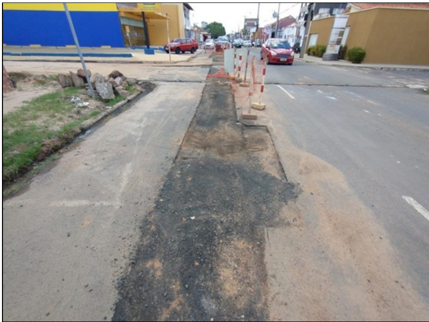
Figura 30 – Rachaduras oriundas da recomposição de valas na Av Campos Sales
