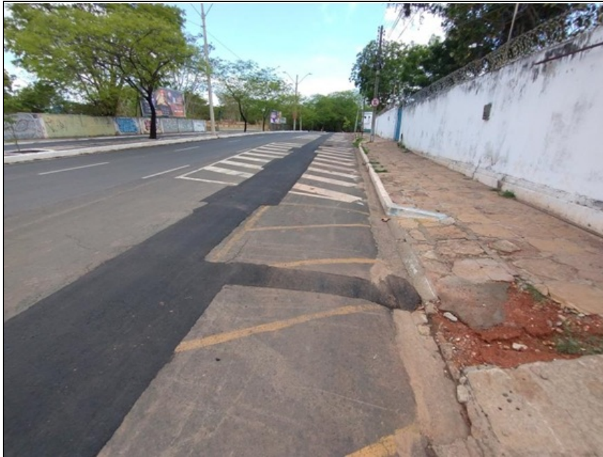
Figura 16 – Recomposição irregular e danos à calçada na Av Miguel Rosa. Destaque para a falta de sinalização horizontal na via nos locais de intervenção.
