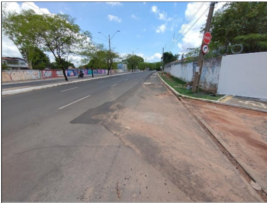
Figura 16 – Recomposição irregular e danos à calçada na Av Miguel Rosa. Destaque para a falta de sinalização horizontal na via nos locais de intervenção.
