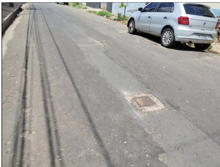
Figura 26 – Recomposição asfáltica com desníveis no cruzamento da Av Campos Sales com R. Anísio de Abreu.
