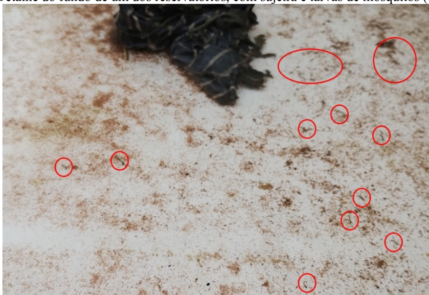
Figura 17 – Detalhe do fundo de um dos reservatórios, com sujeira e larvas de mosquitos (em vermelho).
