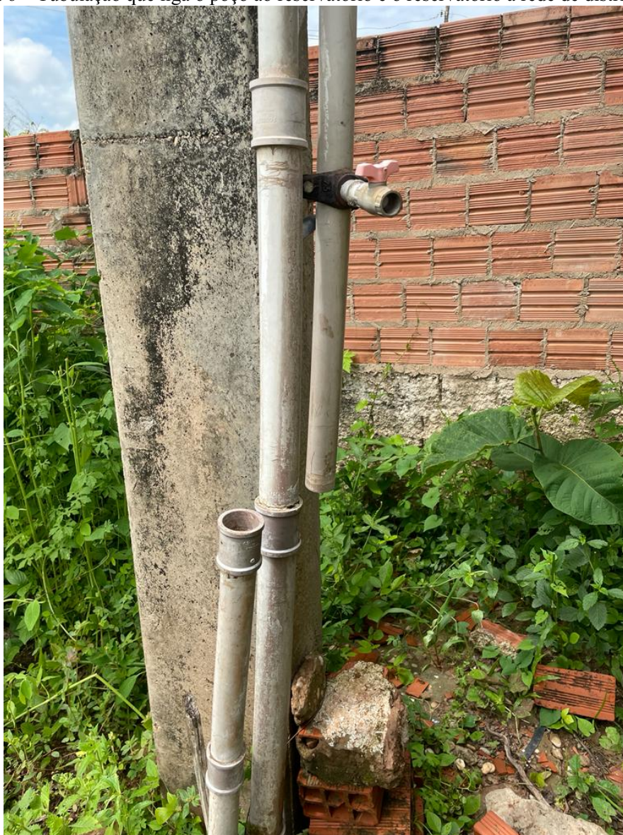
Figura 6 – Tubulação que liga o poço ao reservatório e o reservatório à rede de distribuição.
