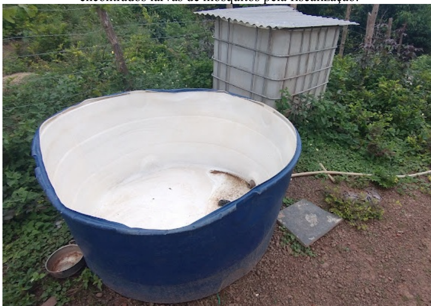
Figura 16 – Reservatórios auxiliares na parte alta. Detalhe para a sujeira acumulada no fundo do reservatório. Foram encontrados larvas de mosquitos pela fiscalização.
