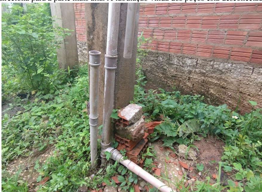
Figura 14 – Trecho de tubulação de abastecimento do reservatório e de distribuição da água. Detalhe para a derivação próxima ao solo da tubulação. Uma que se dirige para a parte baixa da comunidade e a outra (abaixo à direita) que se direciona para a parte mais alta. A tubulação vinda dos poços está desconectada.
