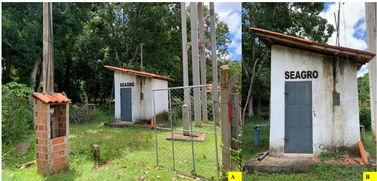
Fonte: Autoria própria (2023) Figura 7 - Reservatório do poço 3 (A) e chafariz desativado (B)
