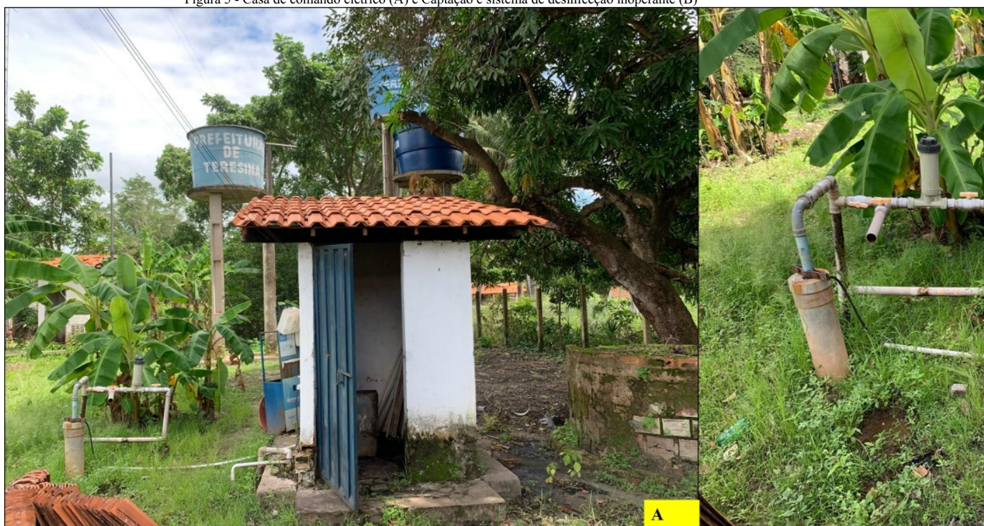
Figura 5 - Casa de comando elétrico (A) e Captação e sistema de desinfecção inoperante (B)
