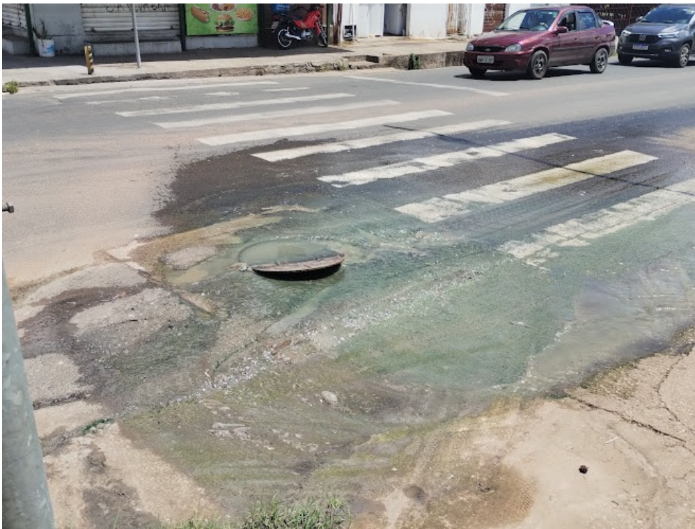
Figura 02 - Esgoto in natura direcionando-se para o sistema de drenagem da região. Deste ponto, o esgoto direciona-se para o Rio Poti, lado esquerdo, na região do Parque Rodoviário.
