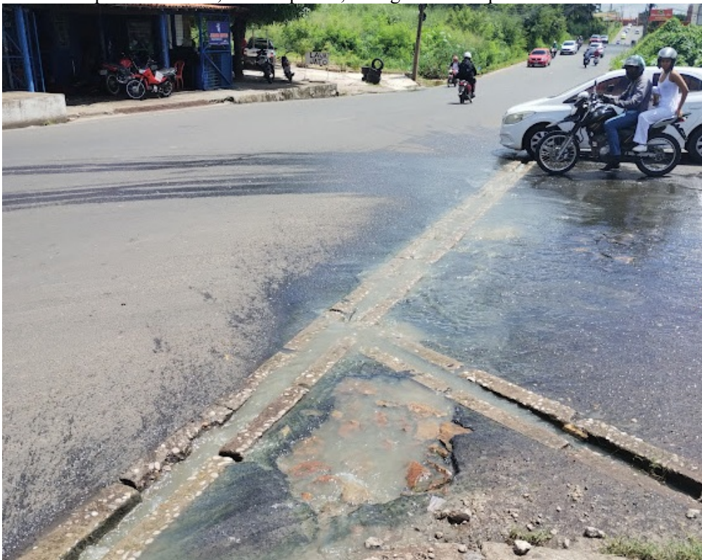
Figura 02 - Esgoto in natura direcionando-se para o sistema de drenagem da região. Deste ponto, o esgoto direciona-se para o Rio Poti, lado esquerdo, na região do Parque Rodoviário.
