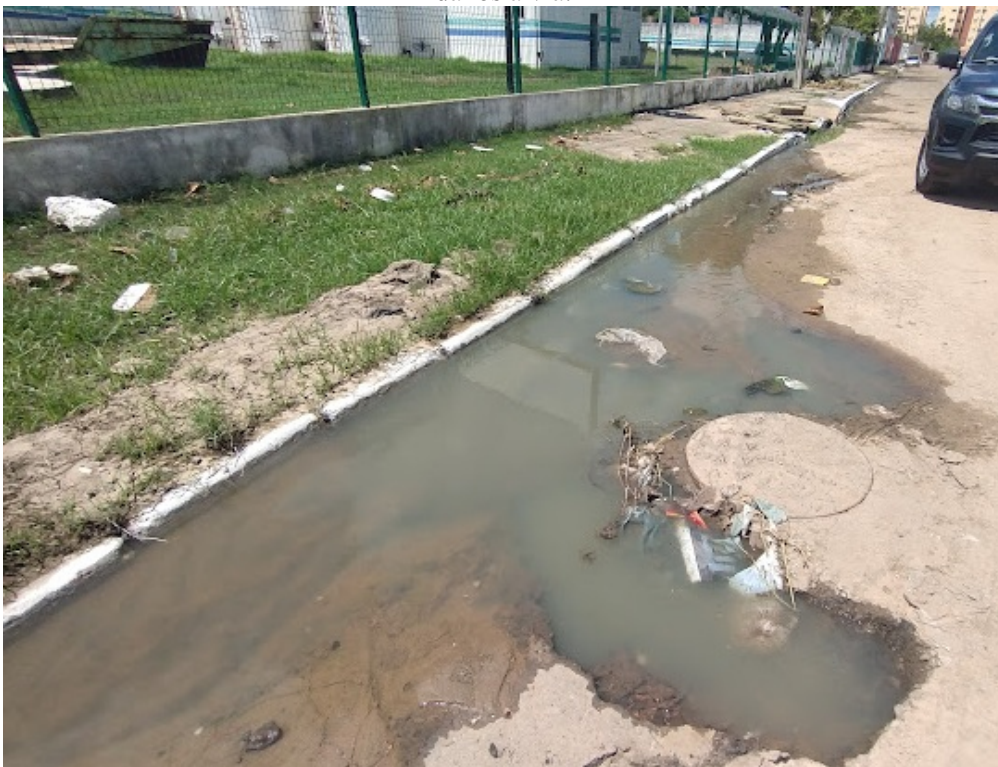
Figura 12 – Poço de visita extravasando esgoto, Av. São Francisco, altura da ETE Tancredo Neves. Detalhe para os danos à via.
