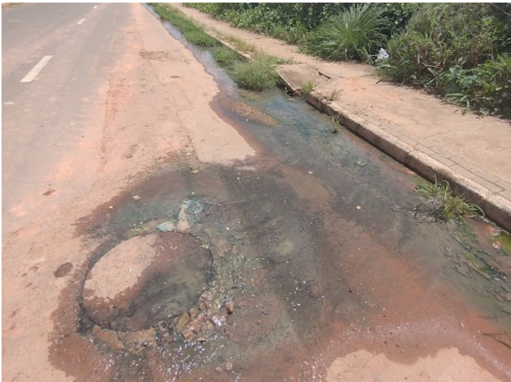
Figura 08 – Poço de visita extravasando esgoto, Av. São Francisco, altura da Grande Reserva Dirceu.
