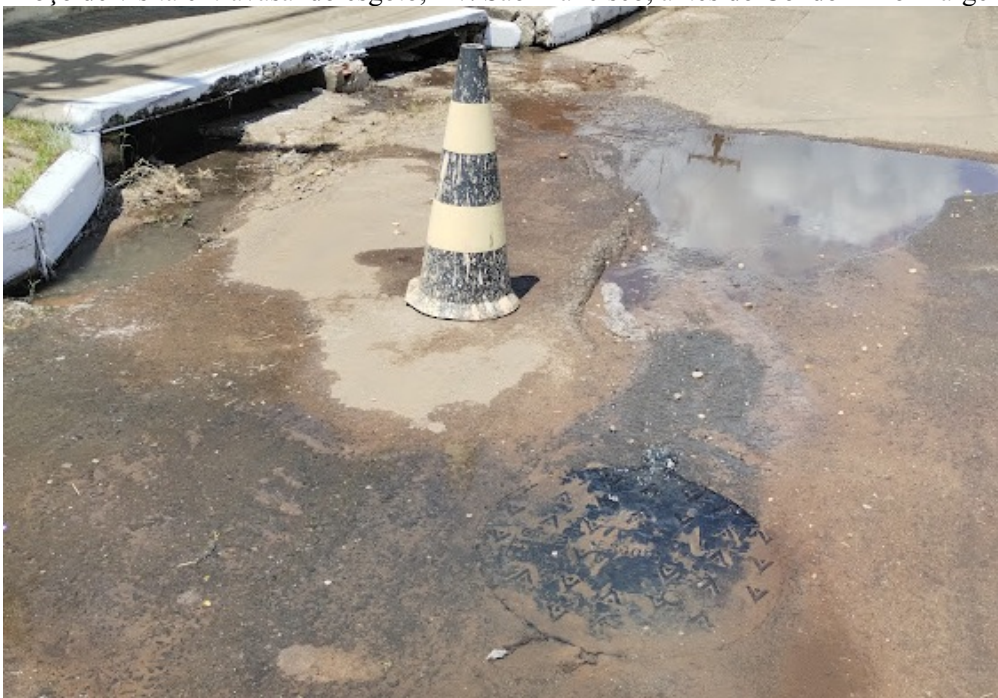
Figura 10 – Poço de visita extravasando esgoto, Av. São Francisco, antes do Condomínio Margens do Poty.
