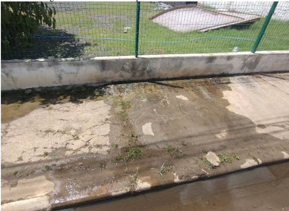
Figura 16 – Minadouros no passeio da ETE Tancredo Neves.
