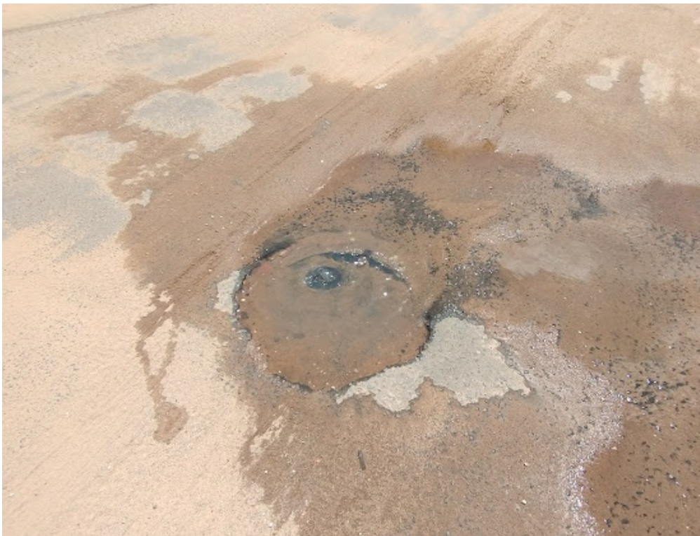
Figura 16 – Minadouros no passeio da ETE Tancredo Neves.
