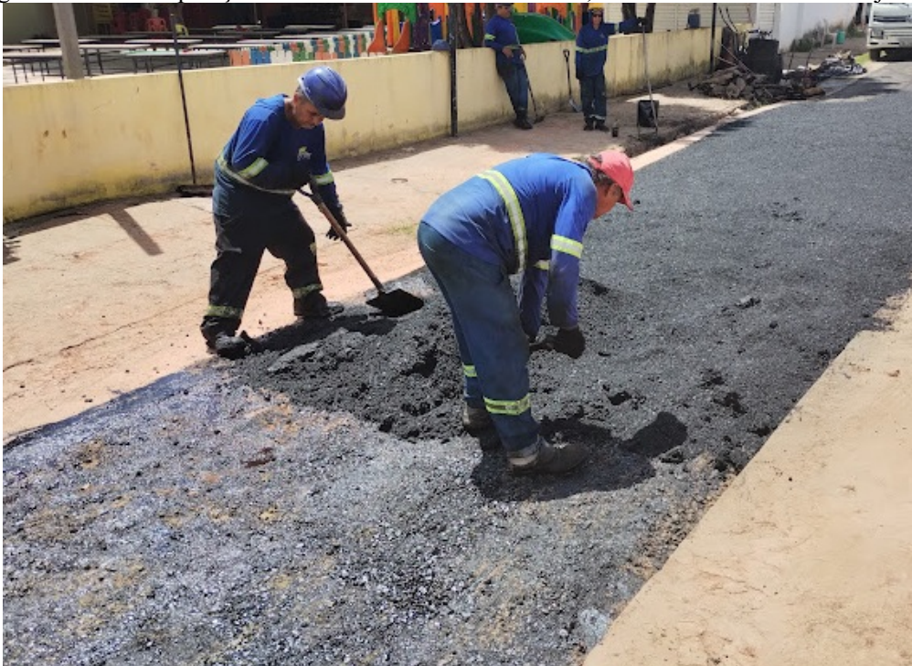
Figura 04 – Recomposição asfáltica na Rua Cícero Soares, ao lado do Restaurante Cajuína.
