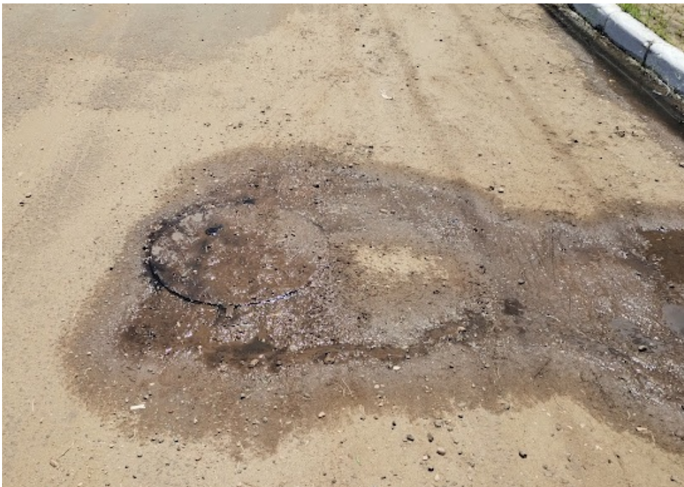
Figura 12 – Poço de visita extravasando esgoto, Av. São Francisco, altura da ETE Tancredo Neves. Detalhe para os danos à via.
