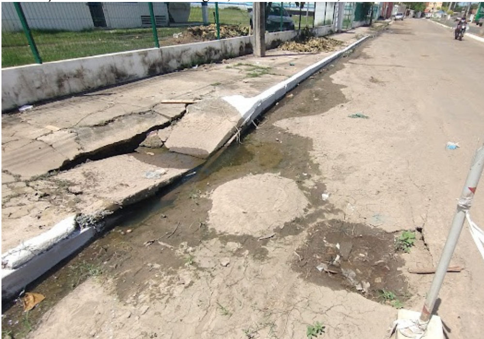
Figura 14 – Poço de visita extravasando esgoto, Av. São Francisco, altura da ETE Tancredo Neves.
