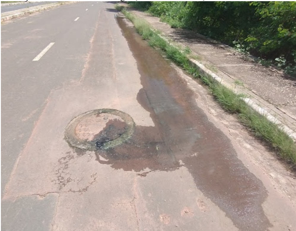
Figura 08 – Poço de visita extravasando esgoto, Av. São Francisco, altura da Grande Reserva Dirceu.
