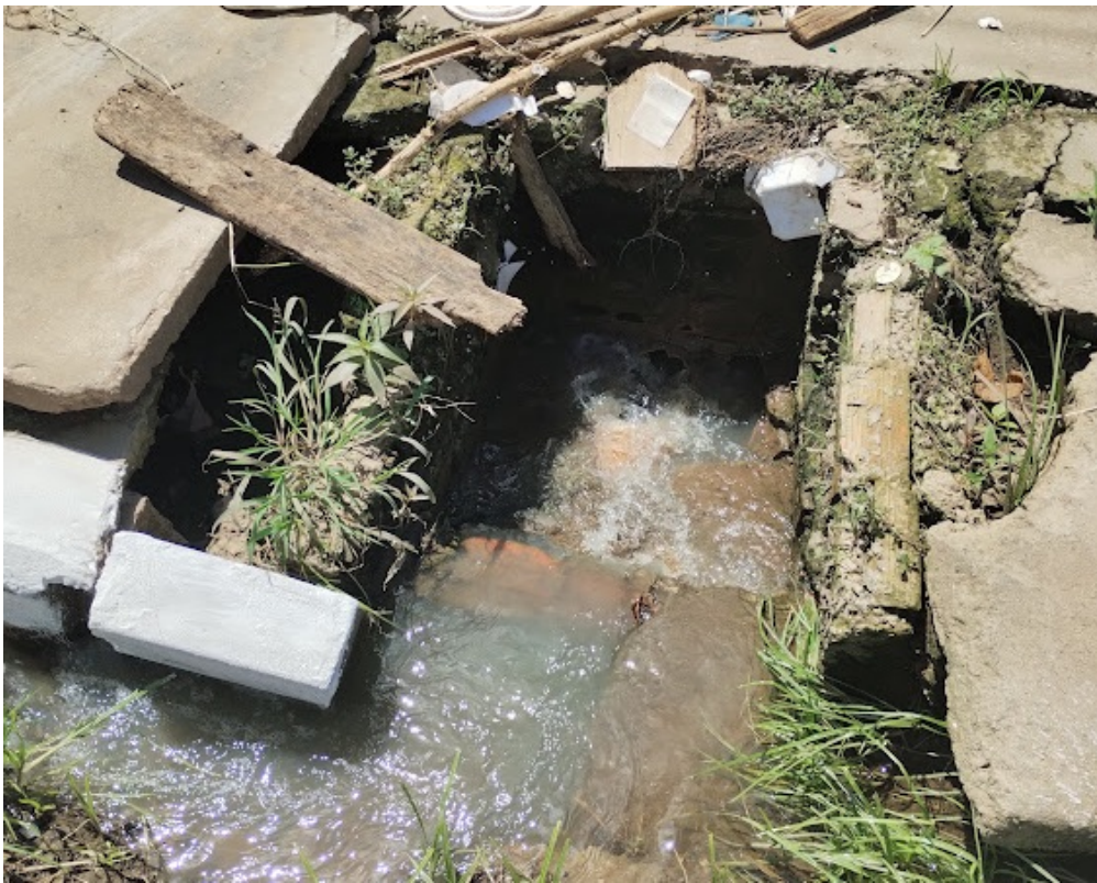
Figura 14 – Poço de visita extravasando esgoto, Av. São Francisco, altura da ETE Tancredo Neves.
