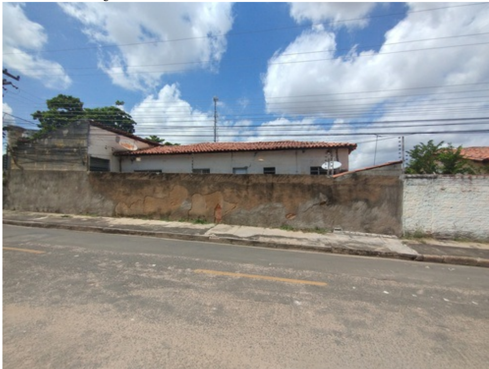
Figura 6 - Residência na frente da EEAT da Rua Arthur Silvestre.
