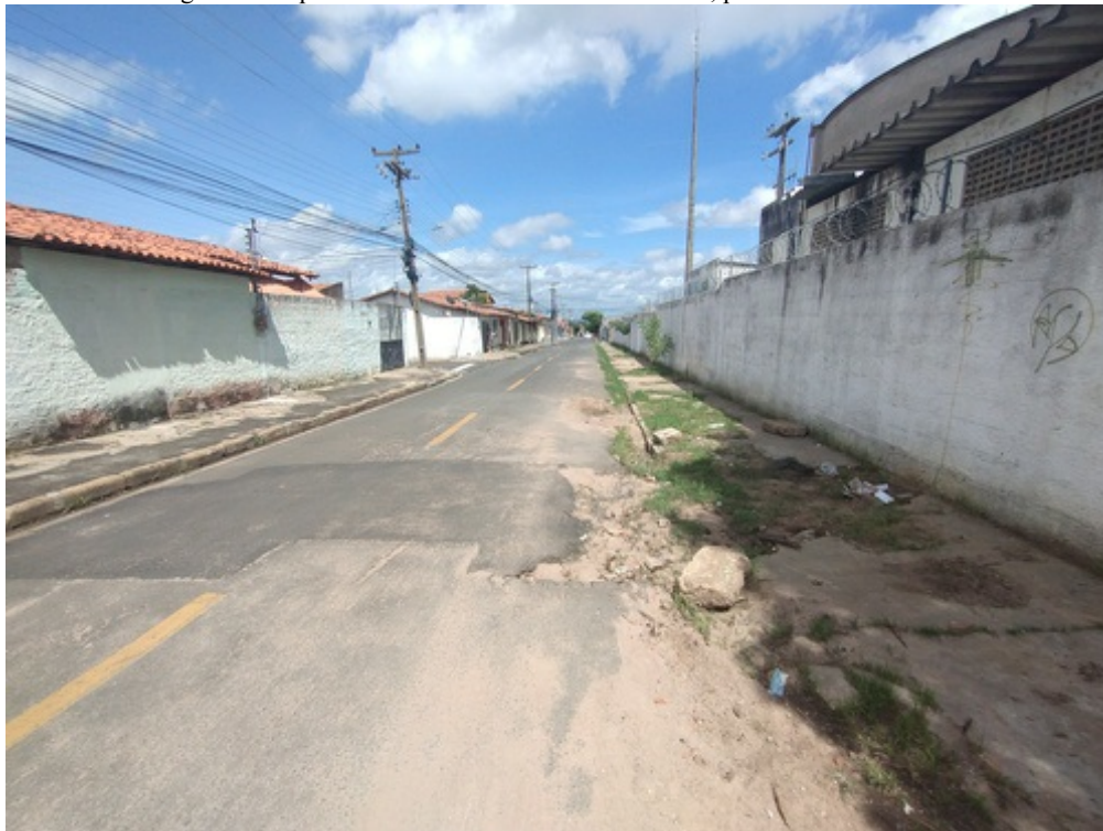
Figura 2 - Reparo executado na rua Arthur Silvestre, próximo ao EEAT-19.
