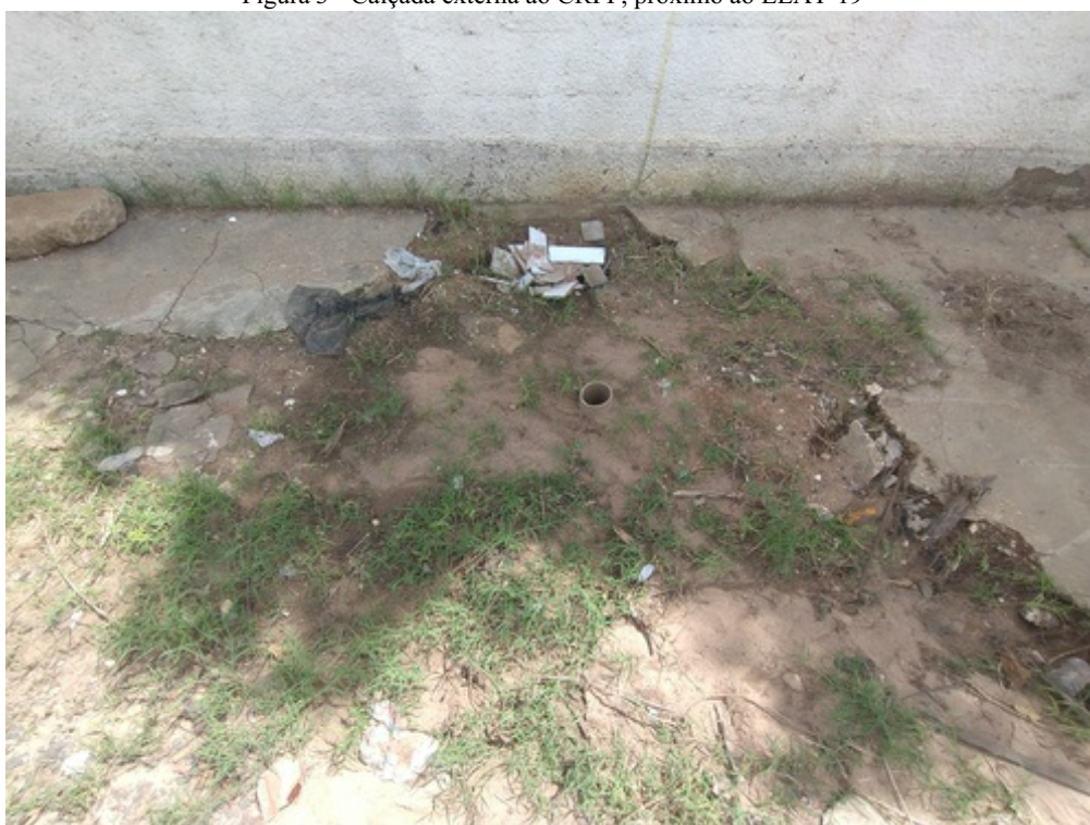
Figura 3 - Calçada externa ao CRPP, próximo ao EEAT-19
