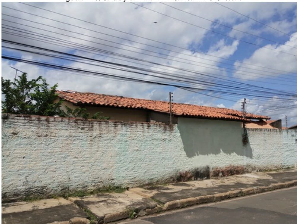
Figura 7 - Residência próxima a EEAT da Rua Arthur Silvestre
