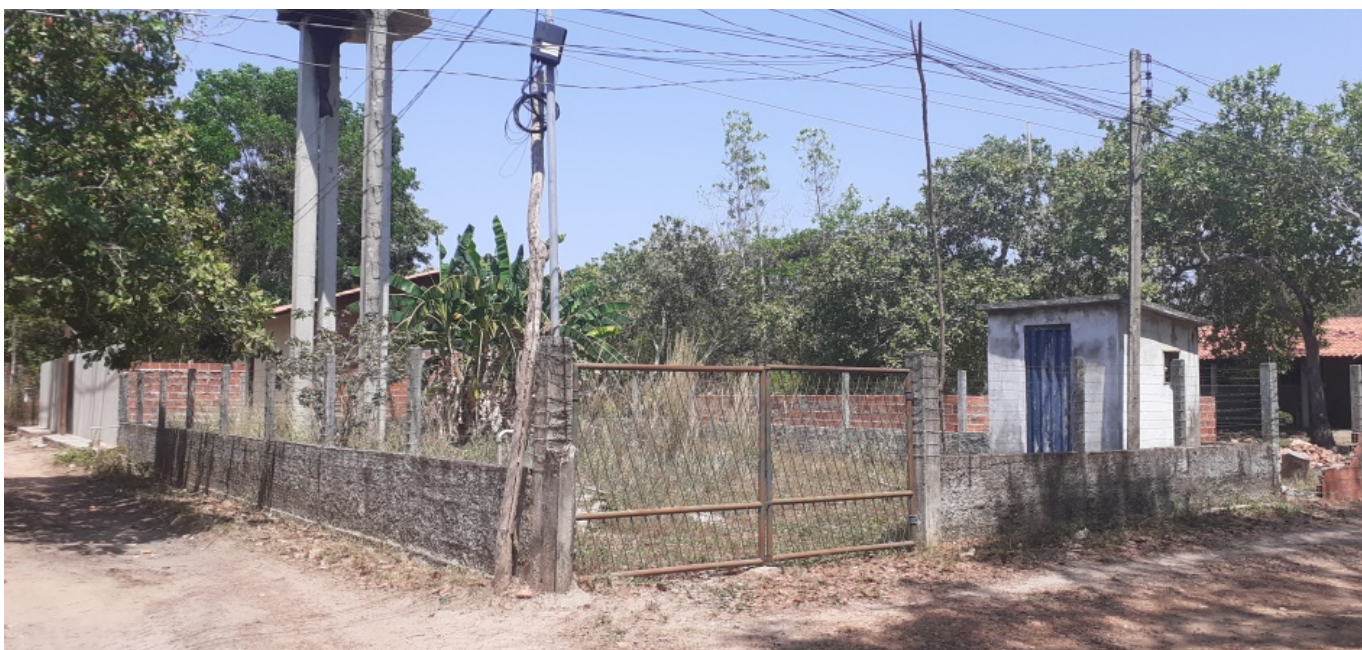
Figura 10 – Poço 03 do Povoado Taboca do Pau Ferrado, isolamento do poço.
